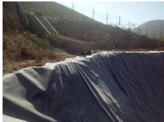
Encuentro entre descarga y revestimiento terminada
