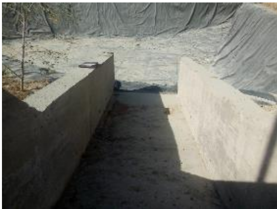
Encuentro entre descarga y revestimiento terminada
