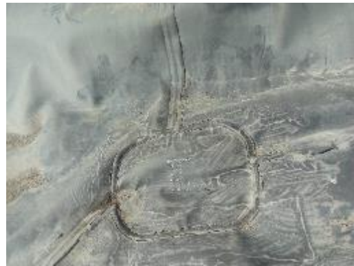
Parches terminados y con evidencias de prueba con campana de vacío
