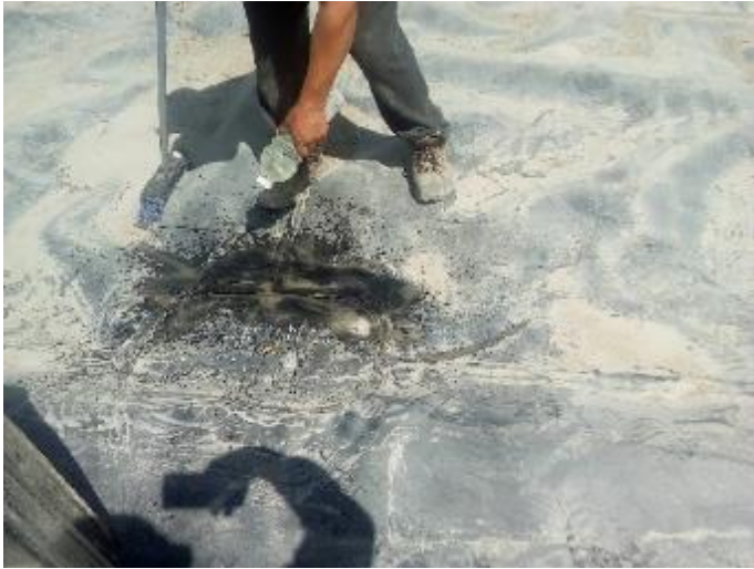
Aplicación de solución jabonosa sobre parche y prueba con campana de vacío
