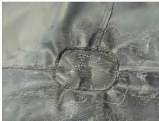
Parches terminados y con evidencias de prueba con campana de vacío
